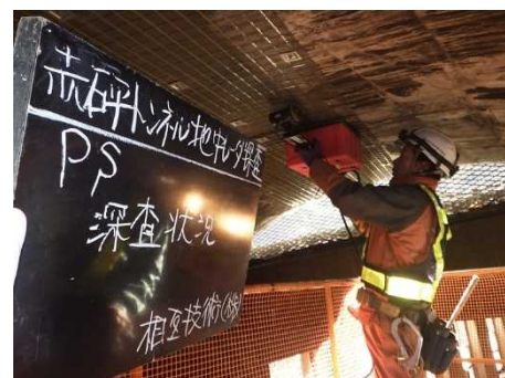
一般国道148号赤石平トンネル
