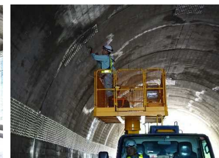
一般国道345号 松陰第一トンネル
