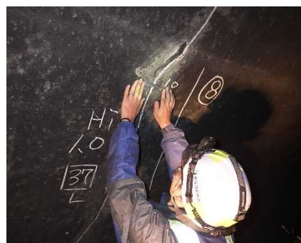
一般国道148号赤石平トンネル
