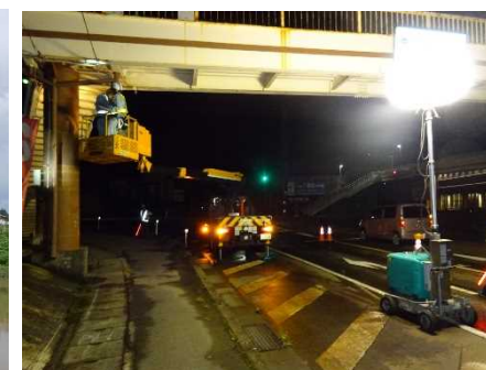
一般国道253号 美佐島横断歩道橋 ※夜間作業
