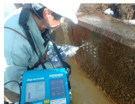
四ツ合第2号排水路(新潟市西蒲区)
